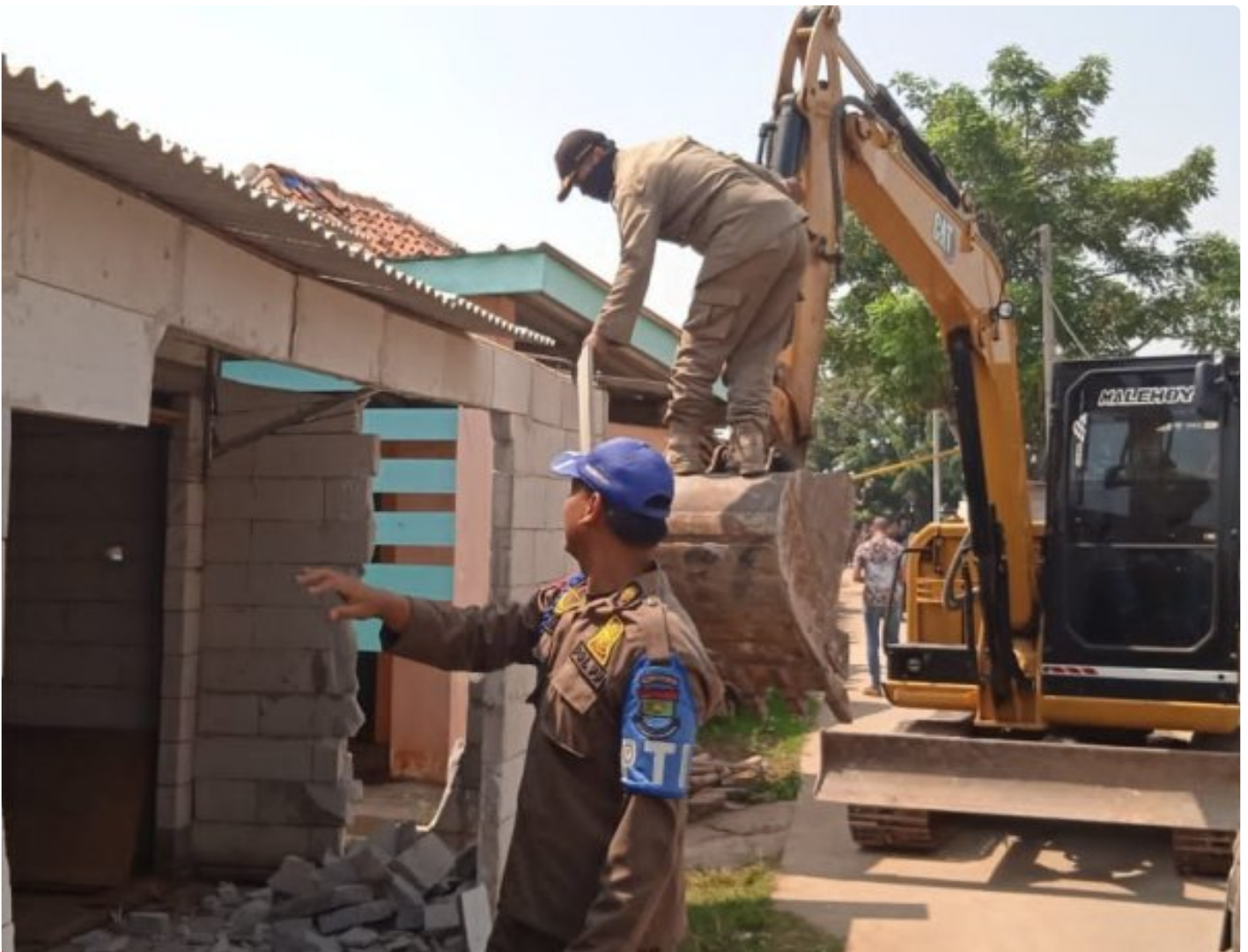
Satpol PP Kabupaten Tangerang saat melaksanakan Pembongkaran Bangunan disepanjang Bantaran Kali Alar Jiban
